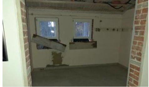
Das neue Pfarrbüro in der Entstehung
