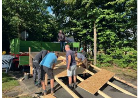
Aufbau der Rampe
