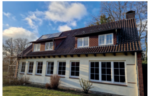
Das Gemeindehaus in Oese vor der Sanierung RM
