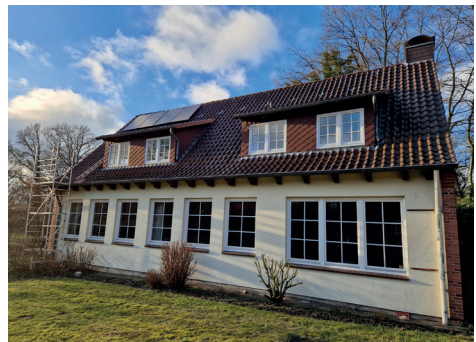
Das Gemeindehaus in Oese mit PV-Anlage
