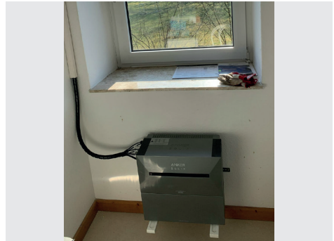
Der Speicher mit Erweiterung Foto H. Lerner
