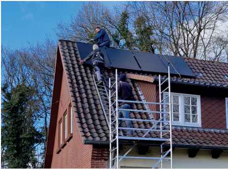
Montage der PV-Module
