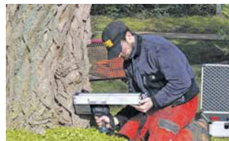
Die Bohrwiderstandsmessung zeigt Hohlräume an.
