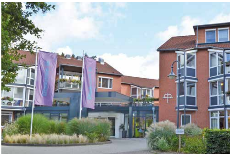
Blick auf den Eingangsbereich des Hauses am Hang
