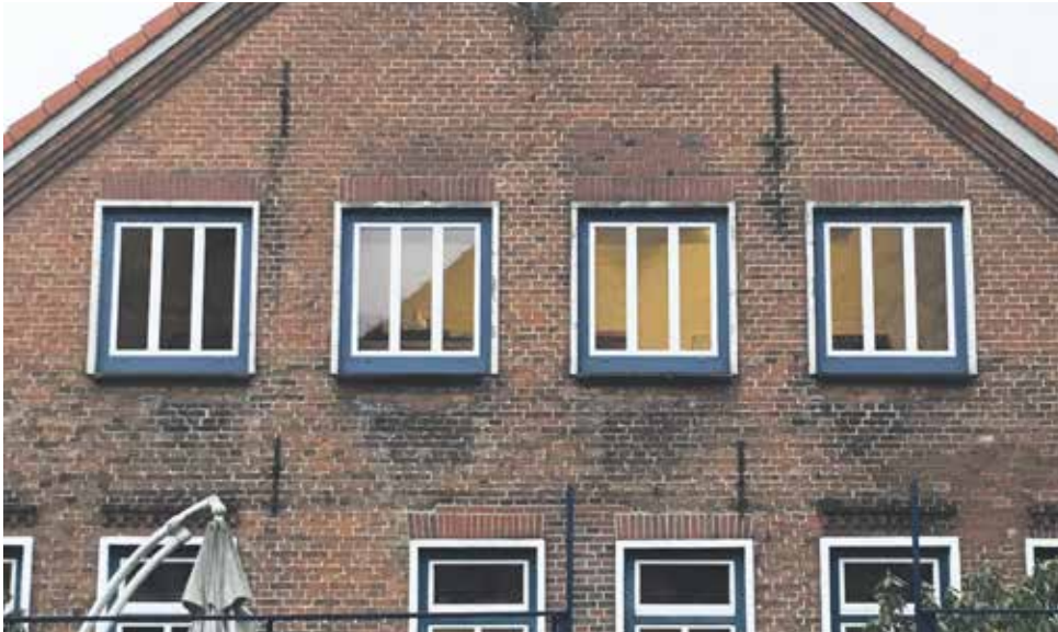
So sehen die neuen Fenster für die Jugendräume aus.
